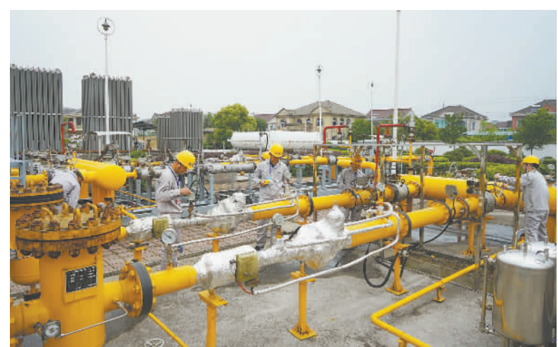
近日，市天然气公司在九屋山门站检修设施设备。通讯员 赵哲摄
