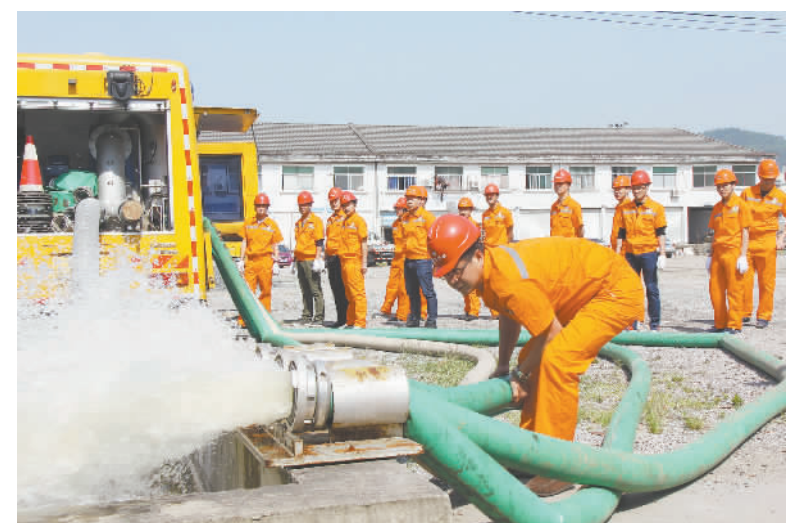
4月20日，排水公司在子陵路防汛仓库举行移动泵车积水抢险演练。通讯员 励夏微摄
