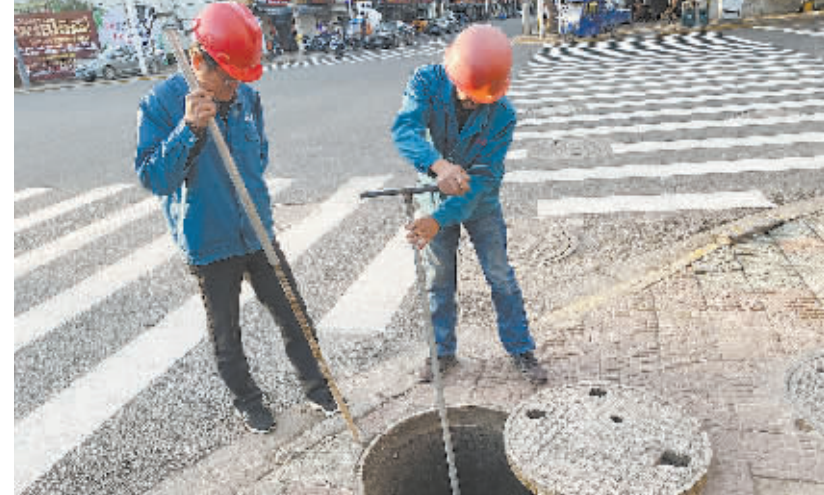
为确保姚西北地区冬季安全供水，近日，市第二自来水有限公司积极防范应对，加大巡查力度，对所有管道及供水设施进行全面排查，做好服务区域内供水防冻保暖措施。图为施工工人正在检修供水管道阀门。
