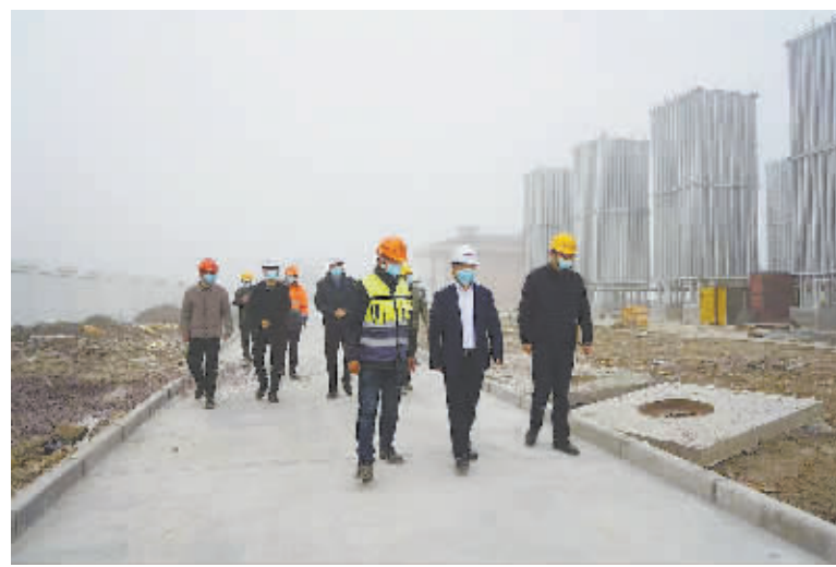
图为余姚天然气保障工程LNG应急气源站工程施工情况督查现场。
