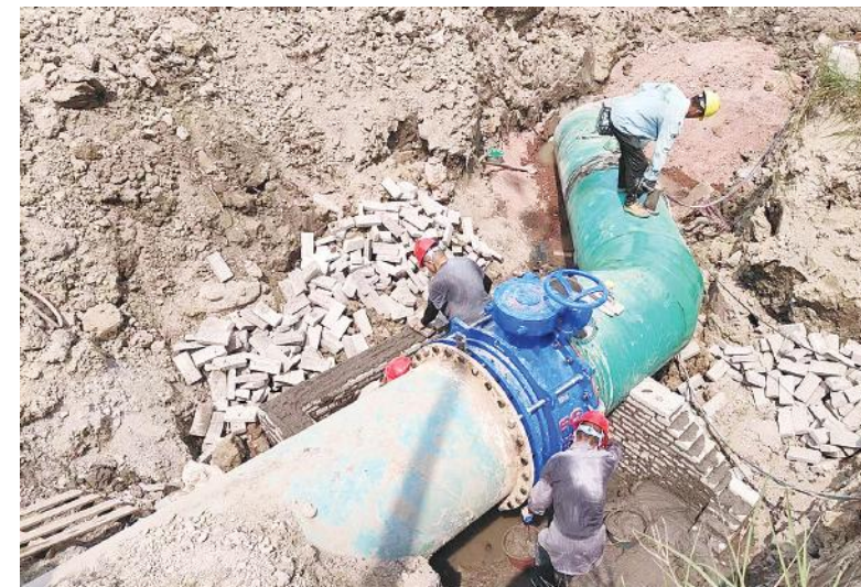
中意宁波生态园DN1000新建给水管四标段施工现场。
