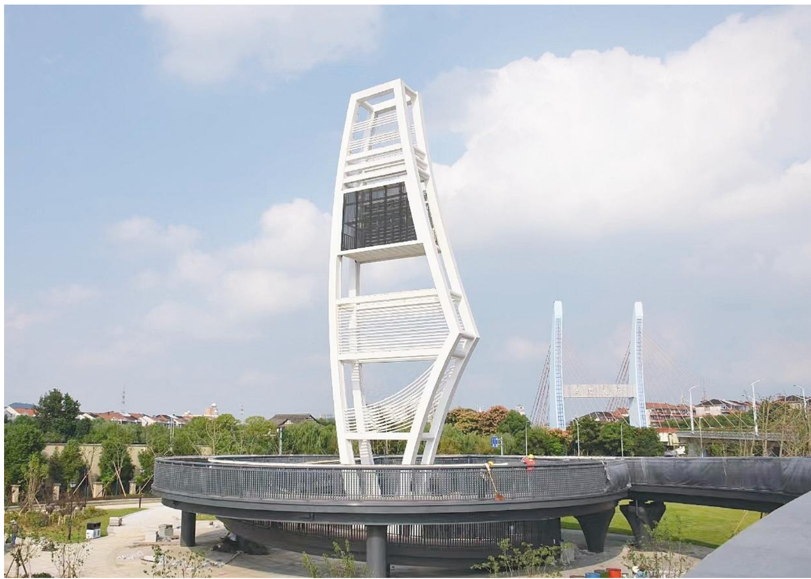
正在建设中的南兰江西路文化休闲广场。
